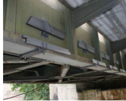
Illustration 13: Absorbeur sur platelage
