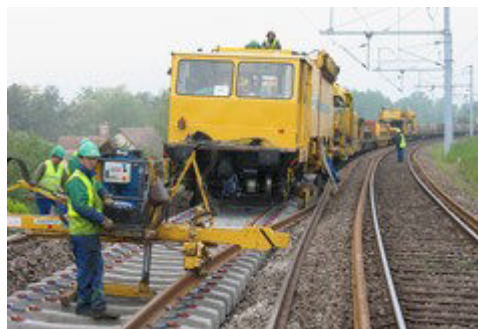
Illustration 9: Longs rails soudés sur travers béton
