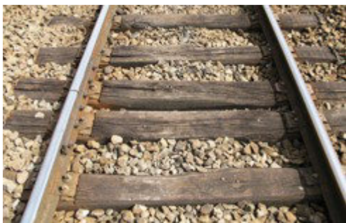
Illustration 8: Rails courts sur travers bois
