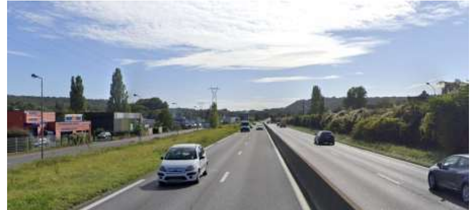
Séquence 3 : entre zone d'activité et mur anti-bruit végétalisé (source : Google streetview)
