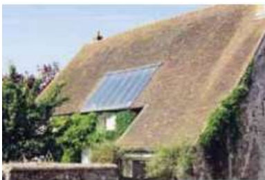
Exemple de pose en toiture :
