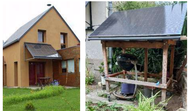
Panneaux thermiques formant une grande marquise au-dessus d'une baie et panneaux couvrant un barbecue.
