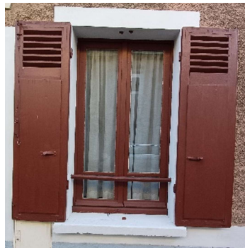
VOILETS PARTIELLEMENT PERSIENNÉS
