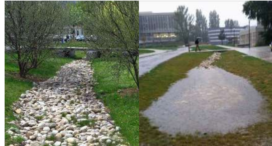
Légende : Exemple de noue aménagée comme une rivière sèche avec un ponton pour la traversée piétonne Source : ©INSA_Lyon_OTHU
