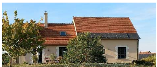
Petits panneaux formant une bande étroite en bas de toiture en ardoise à Rochecorbon (37).
