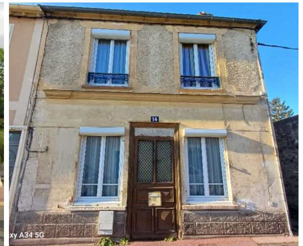
Exemple d'un enduit plâtre et chaux imitant une façade en pierre de taille
