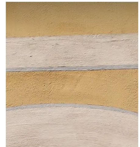
Façade et texture d'un badigeon à la chaux
