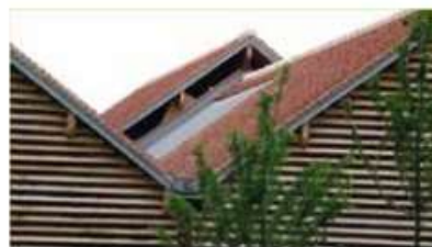
La pose de capteurs entre deux toits limite l'impact visuel.
