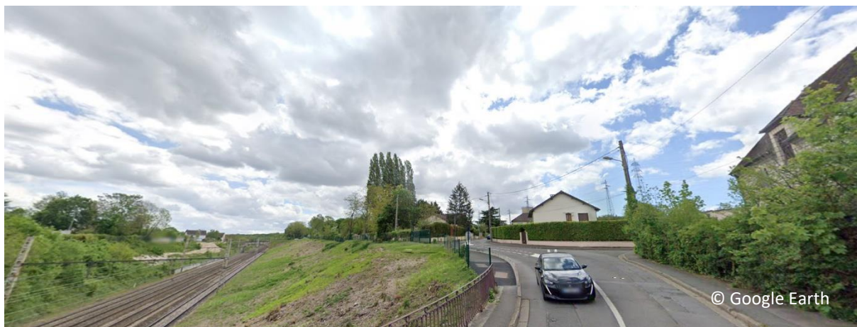
Point de transition Rue de la Forêt entre la zone d'activité et le pont ferré
