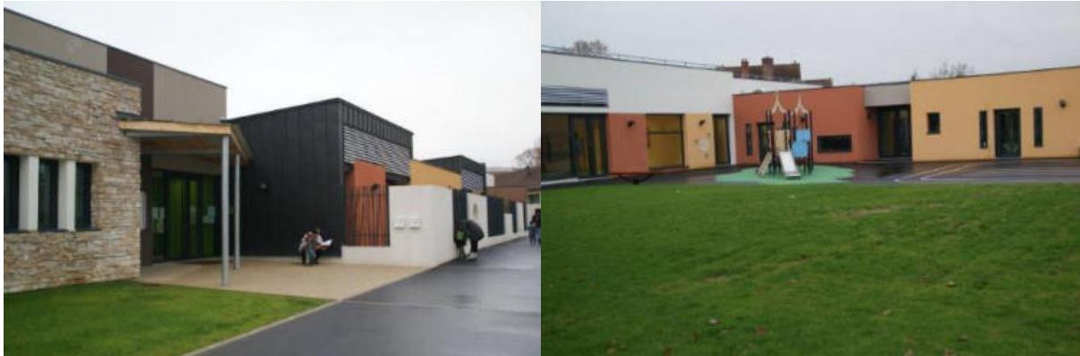
Groupe scolaire de Mainville
