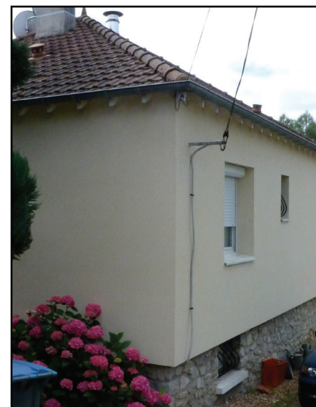
PAVILLON DES ANNÉES 50/60 : ITE RÉALISÉE SUR ÉTAGE COURANT, MAÇONNERIE DU SOUBASSEMENT LAISSÉE VISIBLE
