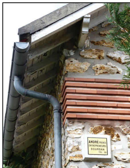
EXEMPLES DE FAÇADES NE POUVANT ÊTRE ISOLÉES PAR L'EXTÉRIEUR
