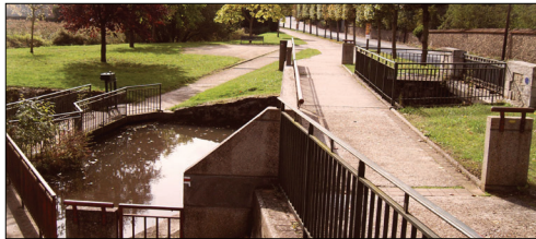
PONT ROUTIER ET PASSERELLE DE LA RUE DU POTELET
