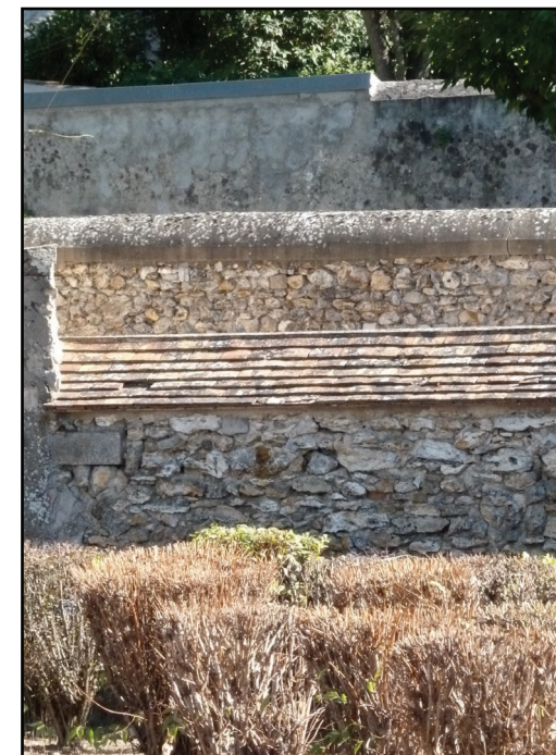
TROIS MURS DE SOUTÈNEMENT RÉGLANT LE DÉNIVELÉ, DEPUIS LA RUE DU MOULIN DU ROI
