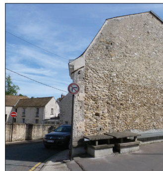
PIGNON DE TYPE 1 EN MOELLONS SIMPLEMENT JOINTOYÉS SUR UNE MAISON DE VILLE
