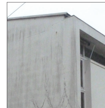
BÂTIMENT NÉO MODERNE DES ANNÉES 80
