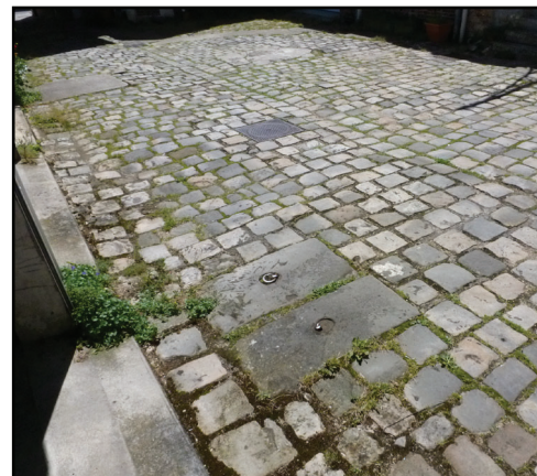
EXEMPLE DE MAINTIEN DE PAVÉ ET ANCIENNE FOSSE SCEPTIQUE
