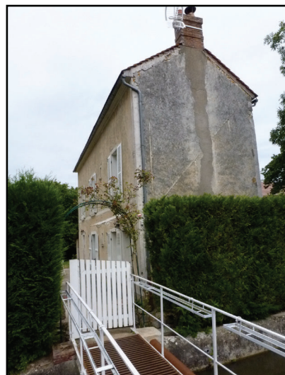
RÉFECTION D'ENDUITS MINCE SUR PIGNON
