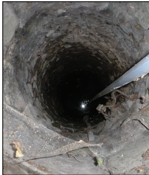
VUE INTÉRIEURE DU PUIITS
