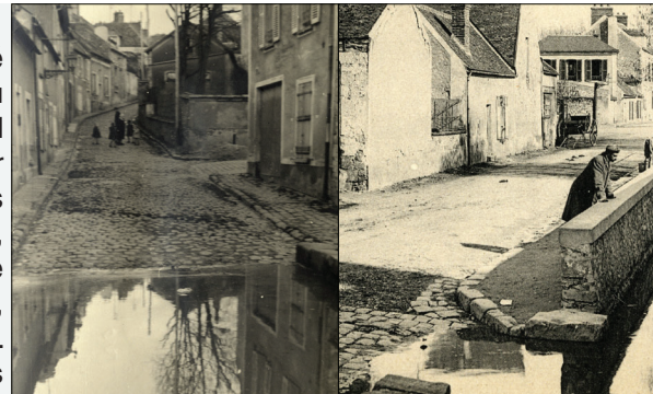
ABREUVOIRS DE LA FOSSE AU CHEVAUX (g.), ET DE LA PORTE D'ÉTAMPES (d.)
