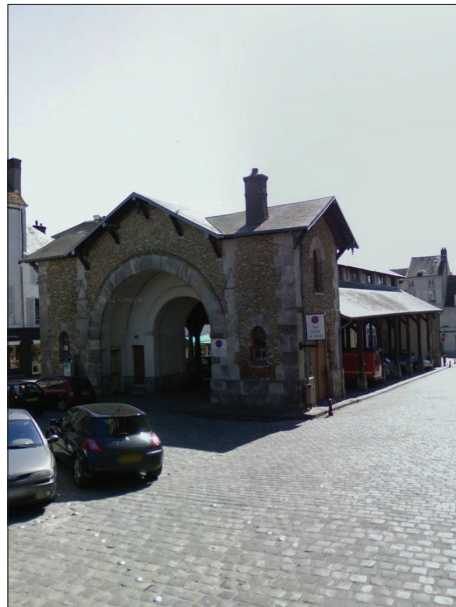
HALLE (PLACE DU GÉNÉRAL DE GAULLE)
