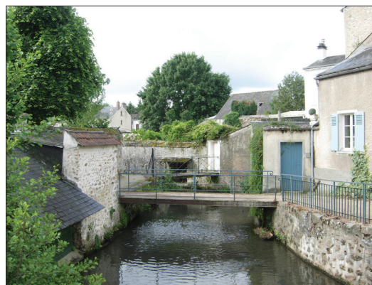
L'Orge est canalisée dans le centre ville. Le Mort-Rû, bras secondaire de l'Orge, a été recouvert sur certains tronçons comme dans la rue Jubée de la Pérelle.
