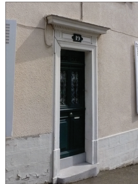
ENDUIT TALOCHÉ RÉCENT AUTOUR D'UN ENCADREMENT DE PORTE CONSERVÉ
