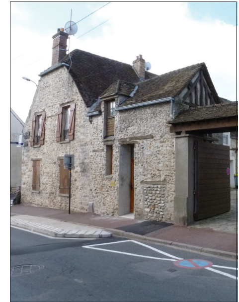
PIOCHAGE TOTAL ET POSE DE FAUX LINTEAUX EN BOIS RAPPORTÉS EN FAÇADE
