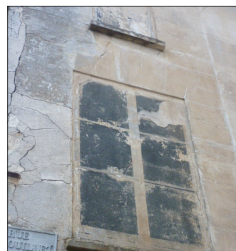
ENDUIT PLÂTRE ET CHAUX À RE- FENDS ET TROMPE L'OEIL
