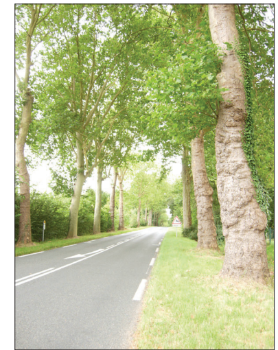
ROUTE DE CORBREUSE (N°10)
