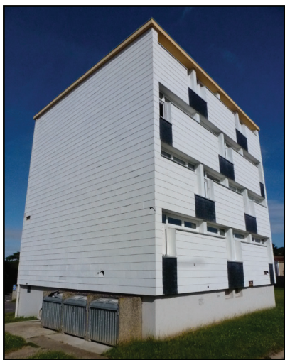
REMPACEMENT D'UNE ANCIENNE ITE SOUS BARDAGE
