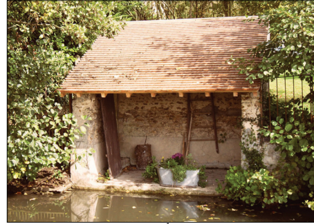
LAVOIR COUVERT CONSERVÉ EN ÉTAT
