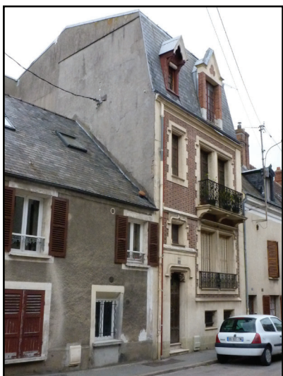
PIGNON DÉJÀ ENDUIT EN CIMENT
