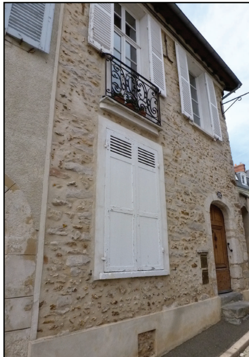
MENUISERIES À PETITS BOIS DU XVIII ÈME SIÈCLE À VALEUR PATRIMONIALE. L'AMÉLIORATION DE LA PERFORMANCE GLOBALE POURRAIT ÊTRE RÉALISÉE AU MOYEN D'UNE DOUBLE-FENÊTRE INTÉRIEURE ISOLANTE ET À CARREAUX UNIQUES.
