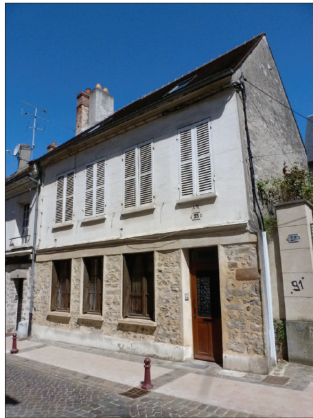
MAISON DE VILLE (RUE SAINT PIERRE)
