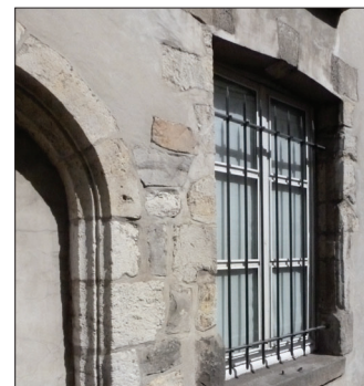
MAÇONNERIES ANCIENNES ET ENDUIT À PIERRE VUE
