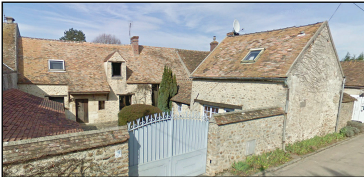
MAISONS DE MARAÎCHER OU D'OUVRIER AGRICOLE À ROUILLON EN FOND DE COUR AVEC BATIMENT EN RETOUR SUR LA RUE
