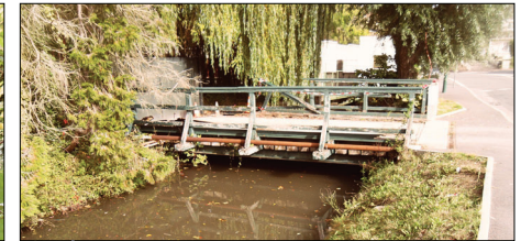
PONT MÉTALLIQUE DE L'ANCIEN MOULIN CHOISELEUR
