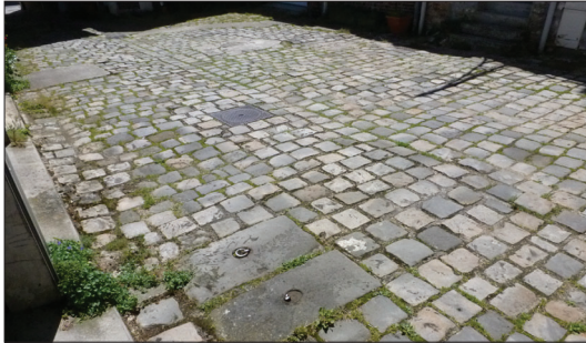
Cour dans le centre ancien rue du faubourg de Chartes. Au premier plan le pavage en grès a été conservé. A l'arrière plan, le sol en gravillon remplace le sol ancien dans la partie rénovée récemment.
