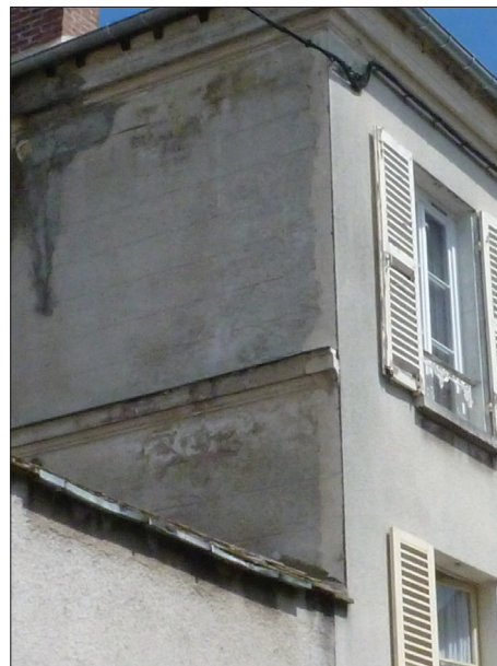
RAVALEMENT EN CRÉPIS CIMENT ET SUPPRESSION DES BANDEAUX EN FAÇADE DE RUE
