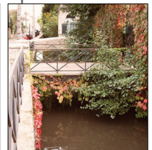
PASSERELLE DE LA PLACE DU CHARIOT
