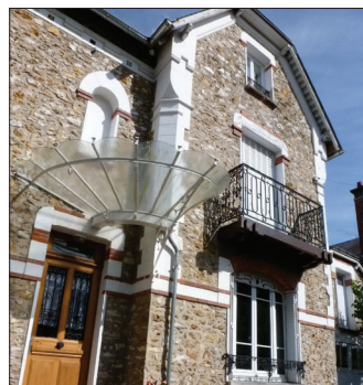
BALCON ET MARQUISE
