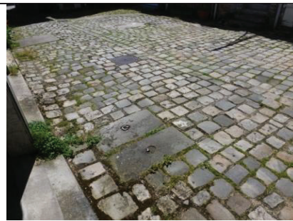
Exemple de maintien des pavés et des dalles de pierre sur une ancienne fosse sceptique
