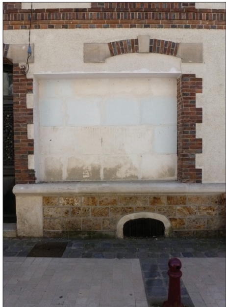
ÉLARGISSEMENT D'UNE BAIE AU RDC
