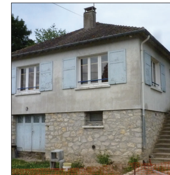
MAISON ANNÉES 60 À SOUBASSEMENT EN PIERRE À CONSERVER APPARENTES
