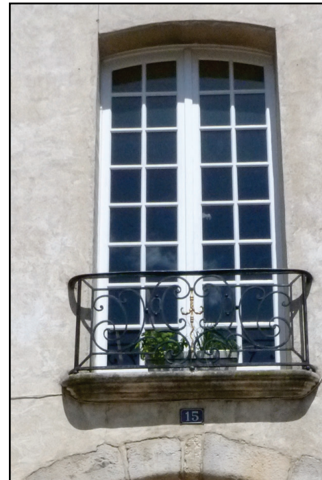
MENUISERIES À PETITS BOIS DU XVIII ÈME SIÈCLE À VALEUR PATRIMONIALE. L'AMÉLIORATION DE LA PERFORMANCE GLOBALE POURRAIT ÊTRE RÉALISÉE AU MOYEN D'UNE DOUBLE-FENÊTRE INTÉRIEURE ISOLANTE ET À CARREAUX UNIQUES.
