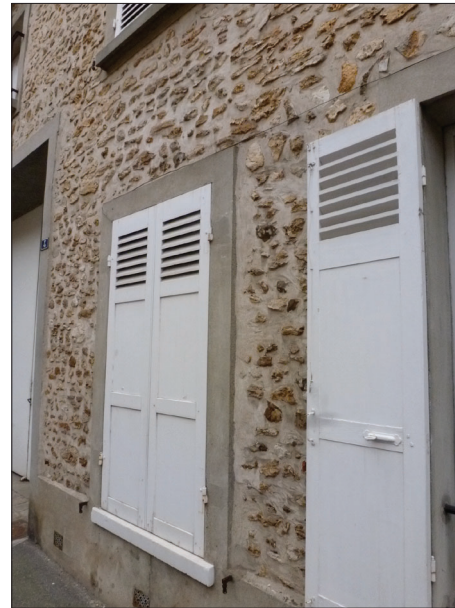
PIOCHAGE TOTALE DE LA FAÇADE ; LES ENCADREMENTS RECONSTITUÉS SONT AU NIVEAU DE L'ANCIEN ENDUIT
