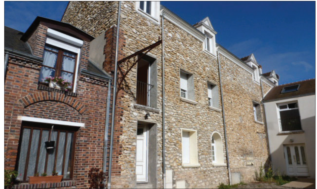
RÉHABILITATION LOURDE AVEC REMPLACEMENT DES PLANCHERS, MODIFICATION DES BAIES ET POSE DE LUCARNES
