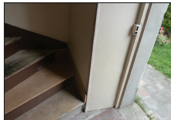
ÉPAISSEUR DE 70CM RELEVÉE SUR UN BÂTIMENT DU CENTRE ANCIEN (PLACE DE LA FORGE)
