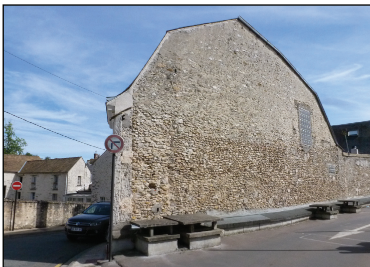
PIGNON EN MAÇONNERIES NON APPAREILLÉES
