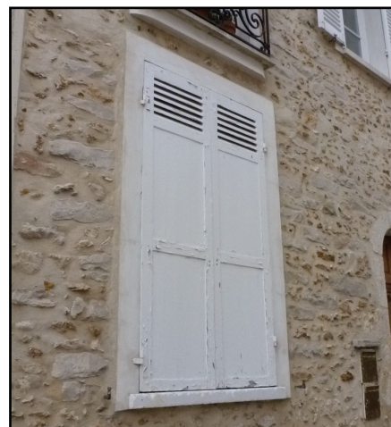
VOILETS BOIS PARTIELLEMENT OU TOTALEMENT PERSIENNÉS (DONT UN RAJOUTÉ SUR UN GARDE-CORPS ANCIEN RÉGIME)
