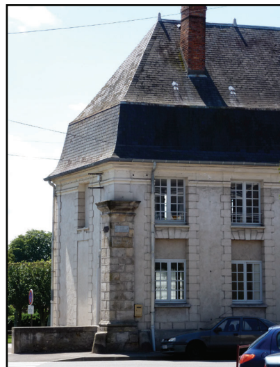
RÉFECTION D'ENDUITS SUR FONDS COURANTS ET DE FAUX CALEPINAGES EN PLÂTRE
