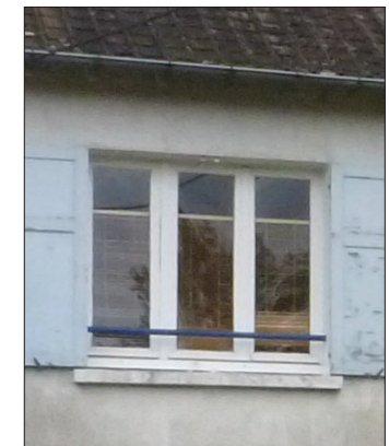
MAINTIEN DES PETITS BOIS EN PARTIE HAUTE ET ÉVOLUTION DE LA BAIE QUI TEND VERS LE RECTANGLE PAVILLONS DES ANNÉES 50 /60
