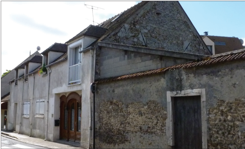
ALTÉRATIONS MULTIPLES : SEUL LE GABARIT CONSERVÉ ET LE PIGNON PERMETTENT DE RECONNAÎTRE CE BÂTIMENT COMME UN BÂTIMENT ANCIEN
