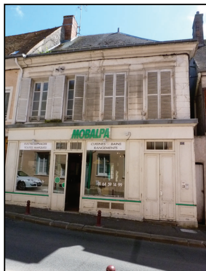
ENDUITS AU PLÂTRE AVEC ENCADREMENTS DE FENÊTRE, DAIS, CORNICHE
