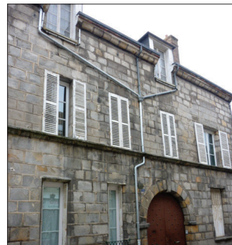
FAÇADE APPAREILLÉE EN GRÈS APPARENT
