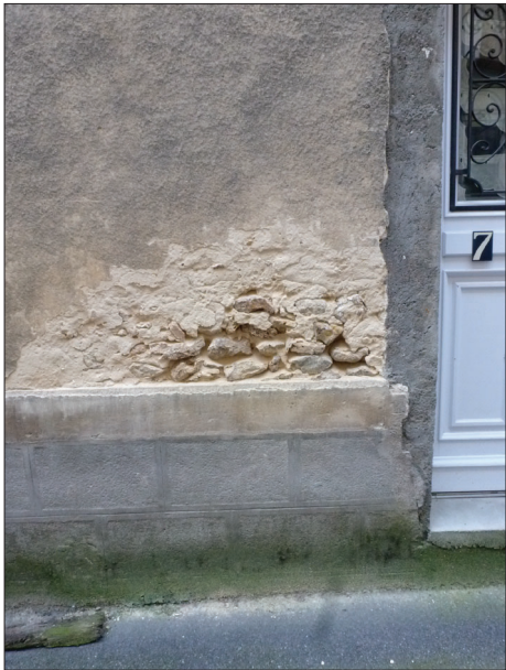
SOUBASSEMENT ET FONDS EN ENDUITS CIMENT
