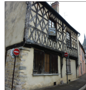
FAÇADE EN PANS DE BOIS À CROIX DE ST ANDRÉ
