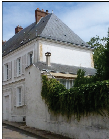
VÉRANDA ORIENTÉE PLEIN SUD AVEC STORES DE PROTECTION RUE TRAVERSIÈRE
