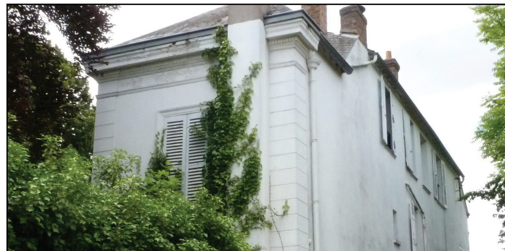
TOITURE INVISIBLE SUR CE BÂTIMENT À R+2
