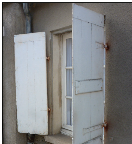
VOILETS PLEINS EN BOIS À TRAVERSES SIMPLES SUR UN BÂTIMENT D'ORIGINE RURALE
