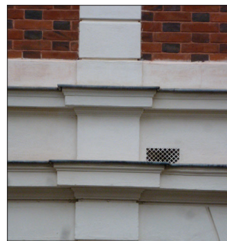
FAÇADE EN BRIQUE ET CALEPINAGE DE FAUSSES MAÇONNERIES
