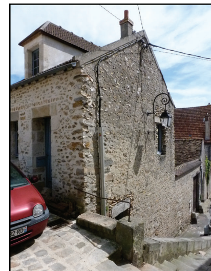
RÉFECTION D'ENDUITS MINCE SUR PIGNON
