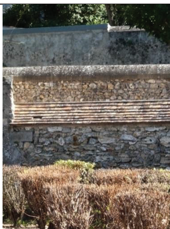
Succession de murs de soutènement réglant le dénivelé
