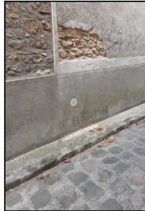
PAVÉS JOINTOYÉS AU CIMENT, BÉTON LAVÉ ET BITUME FORMENT UNE GRANDE PARTIE DES REVÊTEMENTS DE L'ESPACE PUBLIC
