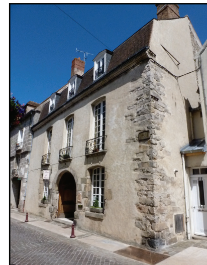
RÉFECTION D'ENDUITS À PIERRES VUES
