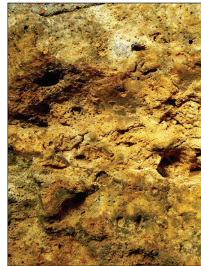
Les murs en meulière
