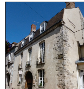
TRAITEMENT IDENTIQUE EN FAÇADE ET PIGNON LAISSANT APPARAÎTRE LE CHAÎNAGE D'ANGLE
