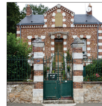
MAÇONNERIES APPARENTES EN ROCAILLAGE FIN
