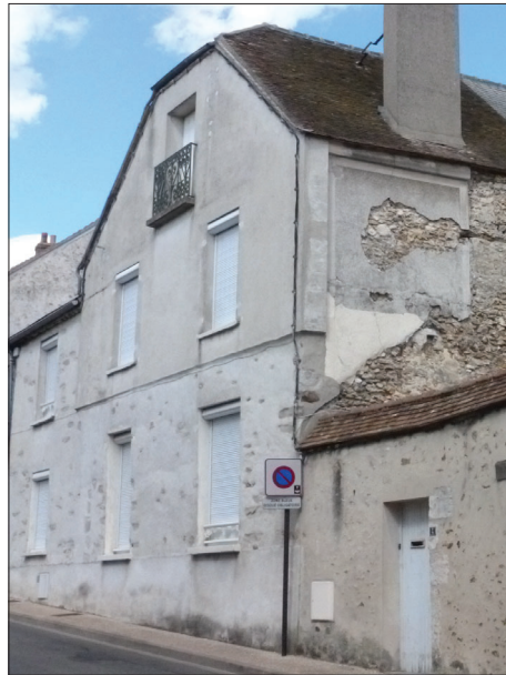
REMPACEMENT DES VOILETS EXTÉRIEURS PAR DES VOILETS ROULANTS EN PVC
