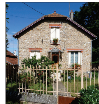
MAÇONNERIES APPARENTES EN PIERRES MEULIÈRES
