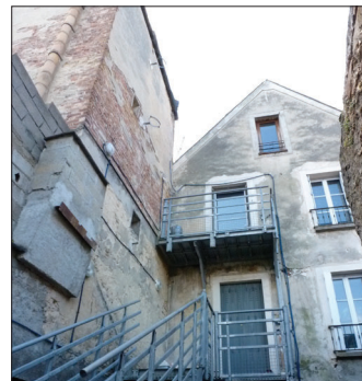
FAÇADE ANCIENNE SUR COUR INTÉRIEURE, ENDUIT SANS CORNICHE NI DÉCOR
