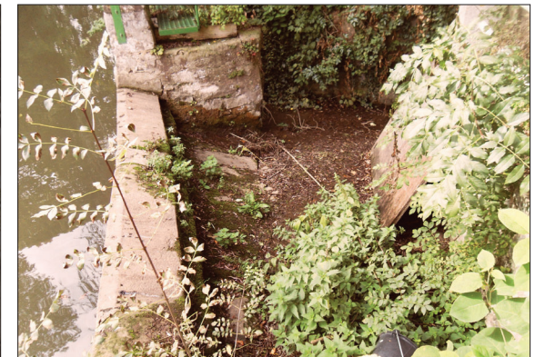
BIEF DE DÉCHARGE ET TROP-PLEIN
