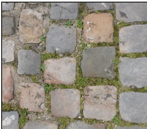
EXEMPLE DE PAVAGE À JOINTS DE TERRE ET SABLE (INFILTRATION DE 30%)
