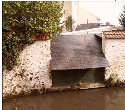
LAVOIR COUVERT CONSERVÉ EN ÉTAT
