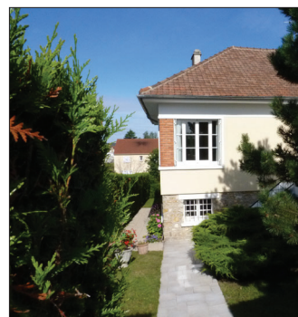
FAÇADE COMPOSÉE EN BRIQUETTE, ENDUIT CIMENT, SOUBASSEMENT EN PIERRES CALCAIRES
