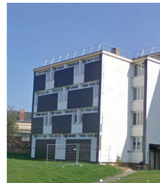
BÂTIMENTS DU CLOS FORTIN (1963)
