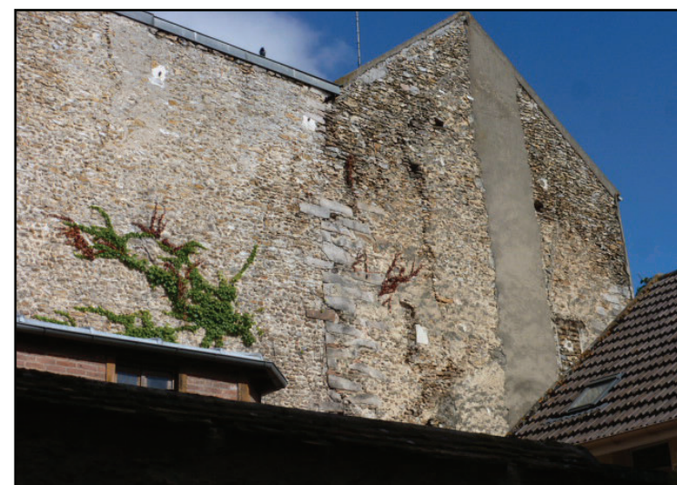
AUTRE PIGNON CONSTITUÉ PONCTUELLEMENT DE MAÇONNERIES APPAREILLÉES
