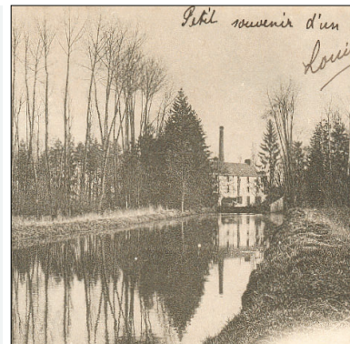
BIEF D'AMENÉE VERS LE GRILLON
