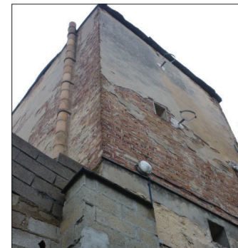
FAÇADE ARRIÈRE EN BRIQUES ALVÉOLAIRES
