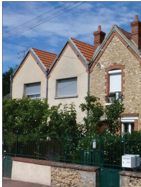
ÉLARGISSEMENT DES BAIES ET RECOUVREMENT DES MAÇONNERIES EN MEULIÈRE
