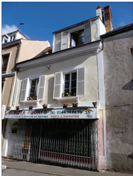
LUCARNES MASSIVES (RUE HAUTE FOULERIE)
