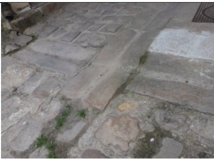
Fils d'eau en pierre dans une ancienne ferme du centre ancien
