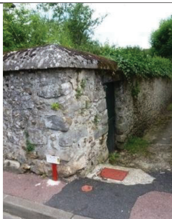
Ouverture piétonnière par percement avec conservation du chaperon
