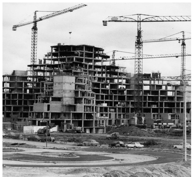
Construction des Pyramides, Evry
