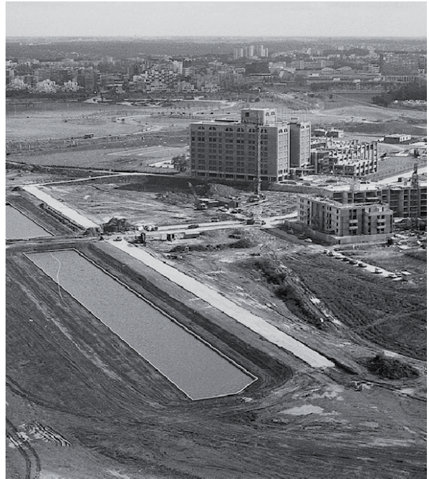
Construction du Canal, Courcouronnes
