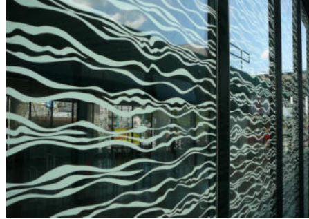
Exemple de vitre limitant les collisions pour l'avifaune (©Batirama)
