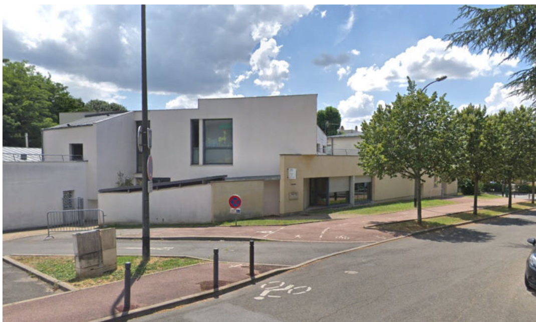
Maison de la petite enfance - Rue des Tilleuls à Chilly-Mazarin
