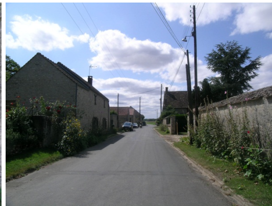
Bandes enherbées et plantations en pied de mur rue de la Mare et au bas de la rue du Château Gaillard
