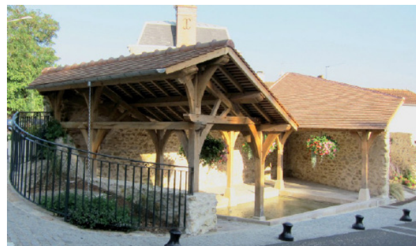
Le Lavoir, réhabilité, et devenu un espace public qualitatif en centre-ville - 08/2011
