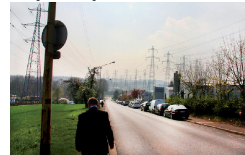
4 : Vue de la descente de Villebon et l'effet «toile d'araignée» des lignes à haute tension - 05/2011
