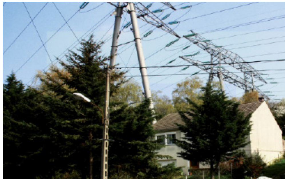
Les lignes à haute tension, au dessus des habitations, rue des Acacias - 05/2011
