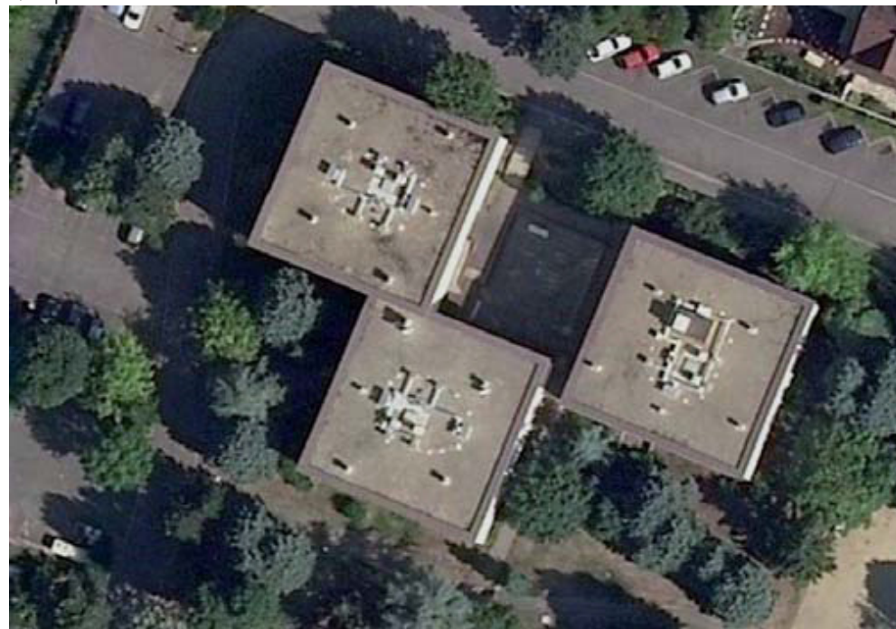
Quelques constructions d'habitat collectif
