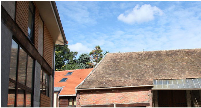
10-12 rue de la Division Leclerc : potentiel +1 logement
