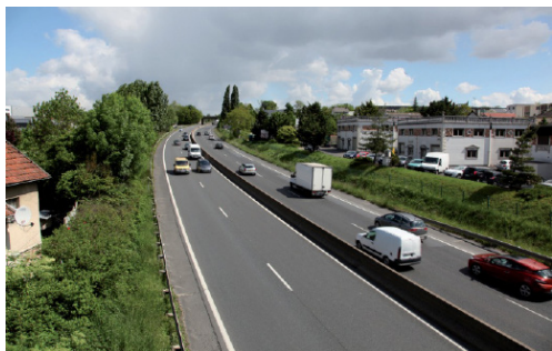
37 : Vue sur la RN 20 depuis le pont de la route de Versailles - 05/2013
