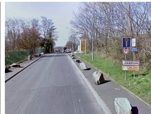
4 : L'entrée de ville n'est pas perceptible dans la zone d'activité, et conduit sur une voie sans issue à cause de la RN 20 - 05/2011
