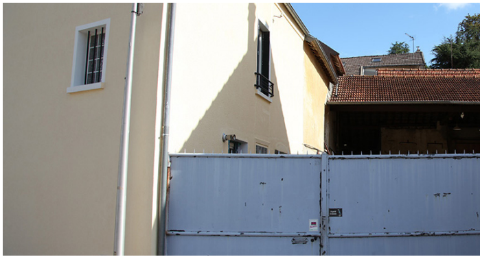
27 rue du Trou Mahet : mutation achevée (demande de 7 rue de la Division Leclerc : potentiel +1 logement régularisation en cours)
