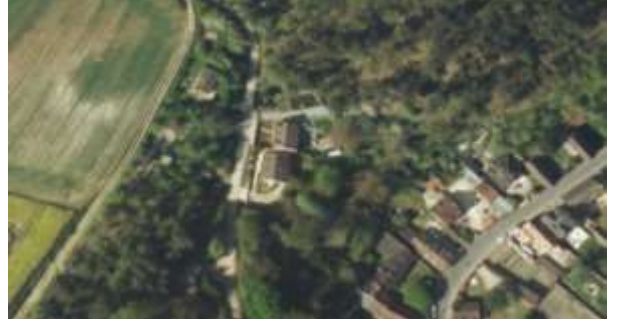
Moulineux – Rue de la Barerie
