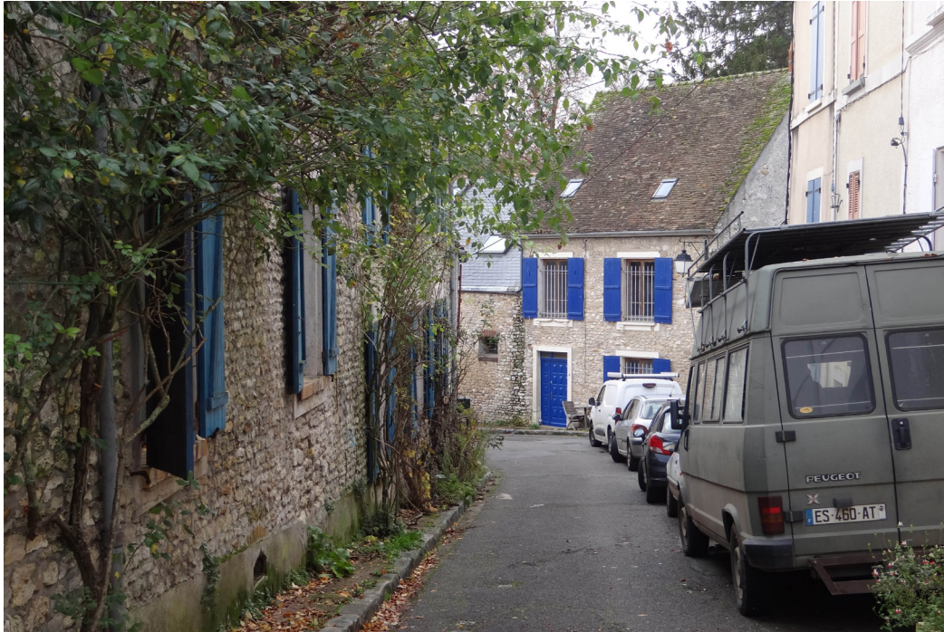
Châlo-Saint-Mars - Rue de la Pelleterie [Fig.1]
