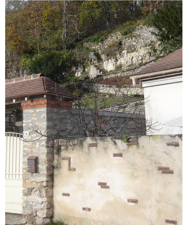
Châlo-Saint-Mars Rampes et soutènement à Beaumont [Fig.1]
