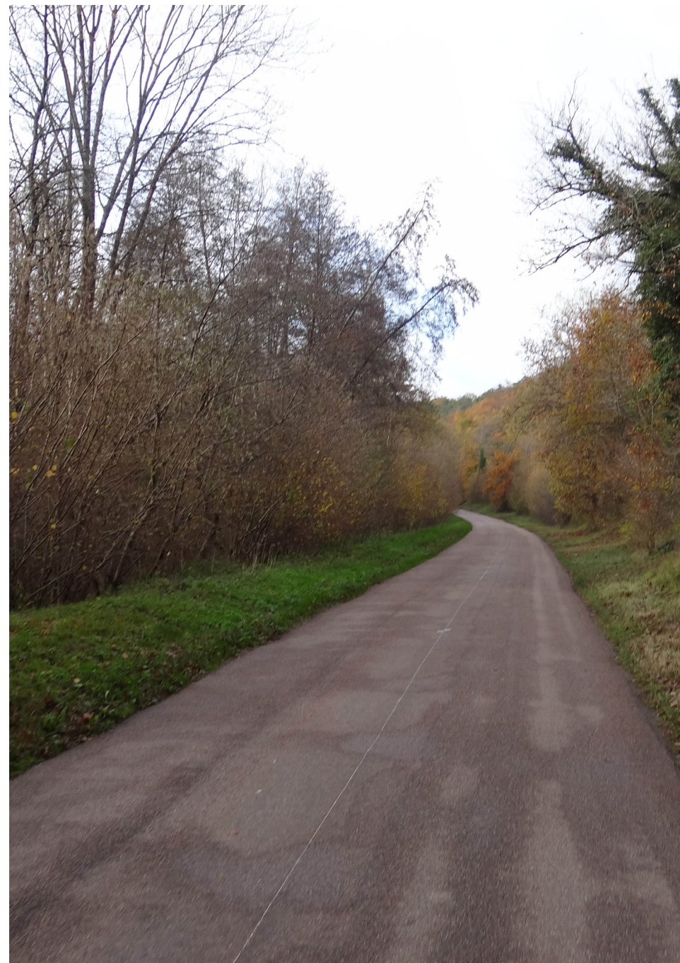
RD160 reliant Châlo-Saint-Mars et Chalou-Moulineux le long de la vallée de la Chalouette
