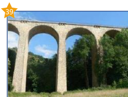
Viaduc des Fauvettes
