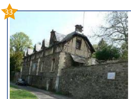
Bâtiment ancien appartenant à l'Institut des hautes études scientifiques.
