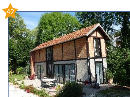
Ancien bâtiment artisanal (structure en fonte et briques) transformé en habitation
