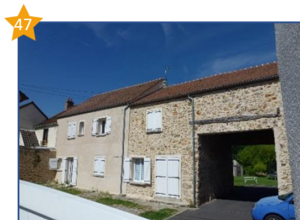
Ancien corps de ferme rue de Montjay
