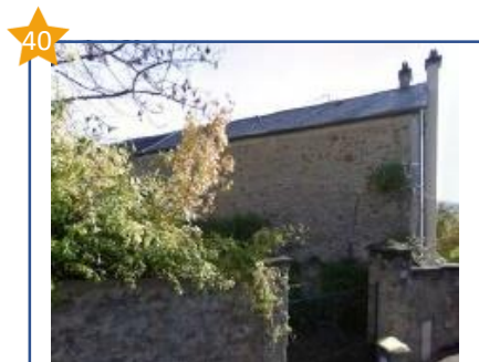
Ancien corps de ferme rue du Docteur Collé
