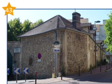
Constructions anciennes du parc de la Grande Maison, qui accueillent aujourd'hui le Centre de loisirs
