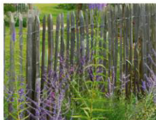
2. Ganivelle en lattes de châtaignier et fil de fer galvanisé sur piquets en bois d'acacia
