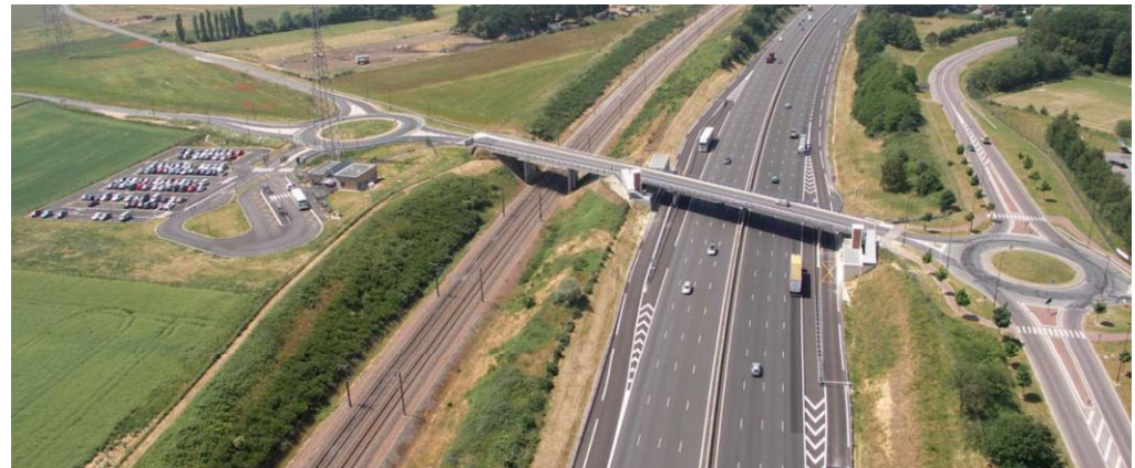
La gare autoroutière de Briis-sous-Forges
