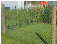
1. Grillage en fil de fer galvanisé du type simple torsion avec piquets en bois d'acacia
