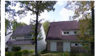
Résidence Les Hauts de Bruyères
