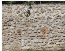
4. Mur de pierre calcaire naturelle ou de meulière jointoyé à pierre vue
