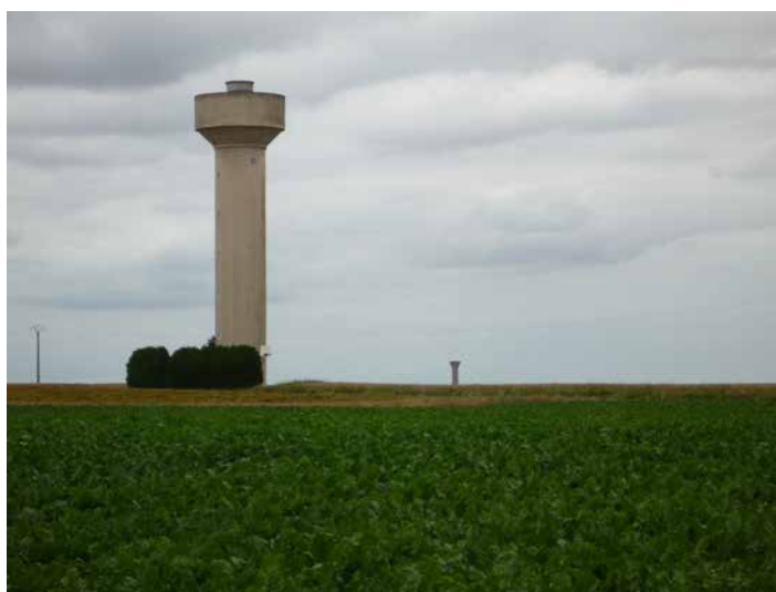
Le château d'eau Photo : Jean-Pierre DENUC
