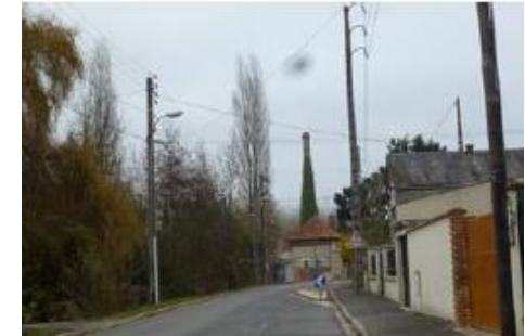
Cheminée route de Guisseray
