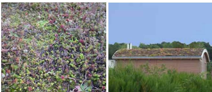
Toit végétalisé sur une maison d'habitation contemporaine.
