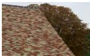
Toiture chamarrée par le mélange des tuiles
