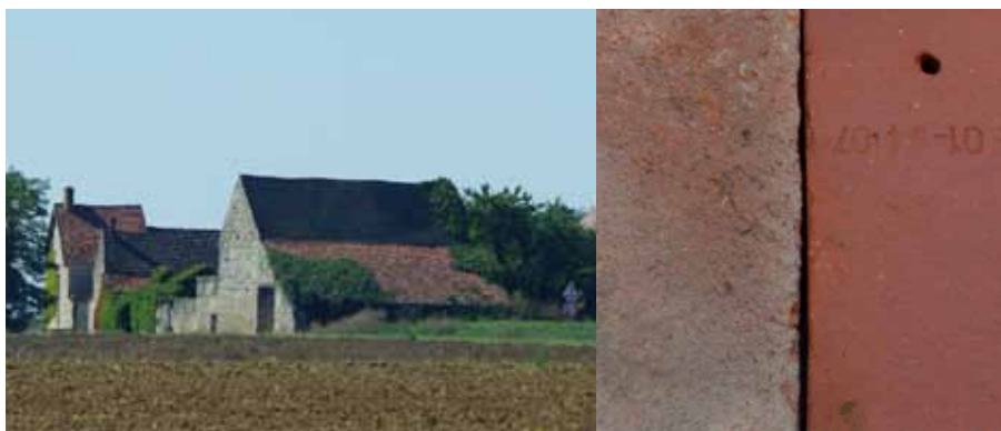
Les tuiles petites, moulées, sont caractéristiques des toitures du Gâtinais français.
