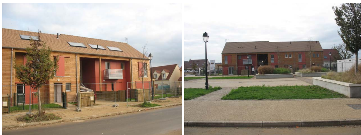
Les deux résidences se font face, reliées par une nouvelle place publique
