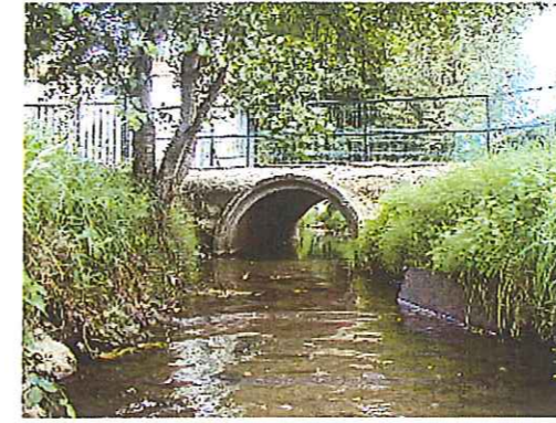
Photo 102 : ouvrage n°2 (vue amont)
