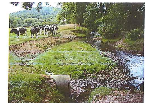
Photo 107 : affaissement berge rive gauche
