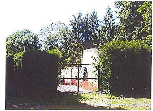
Photo 624: vue depuis l'aval de l'ancienne STEP des Molières
