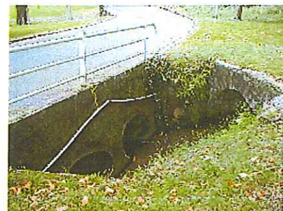
Photo 320 : ouvrages n°14 et n°15
