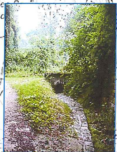
BOU6: Entrée D800 sous voies SNCF
