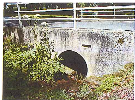
Photo 325a : buse d'alimentation de l'étang
