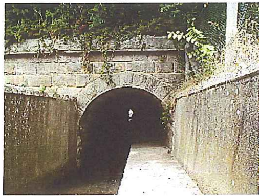
Photo 200 : Ouvrage n°3 (vue amont) la banquette en béton contient le collecteur du SIAHVV
