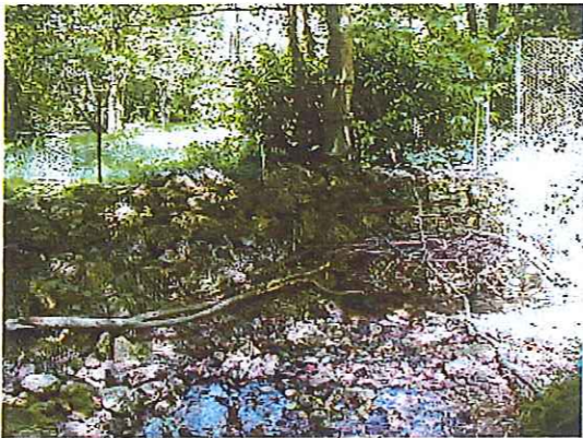
Photo MC 602: courbe en amont de l'étang protection de berges avec des pierres maintenues par du grillage
