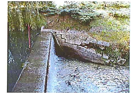
Photo 305 : mur en rive gauche
