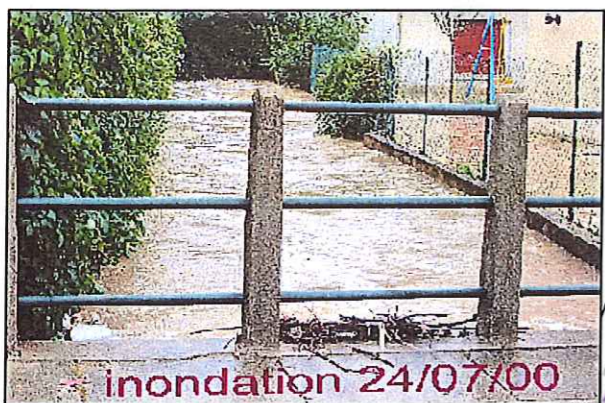
Photo 45 : Pont n°45 sur le Montabé (amont)
