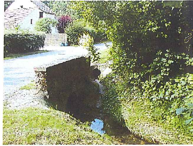
Photo MC 503 : Ouvrage 24 vue aval
