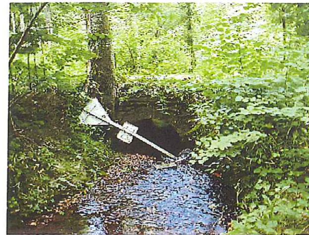
Photo MB 403 : ouvrage 19
