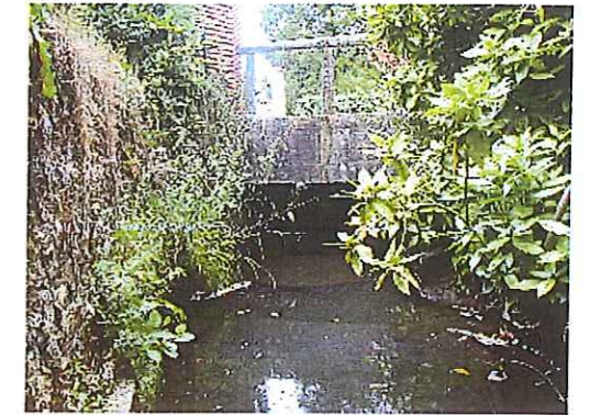
Photo 223 : ouvrage n°6 (vue amont)
