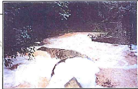
Photo 7 : Chemin de la vallée - ouvrage n°29
