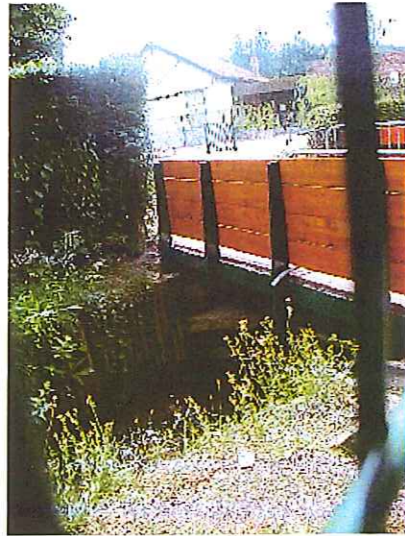
Photo 100 : ouvrage n°1 aval (vue aval)
