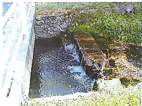
Photo 312 : seuil avec passe batardable
