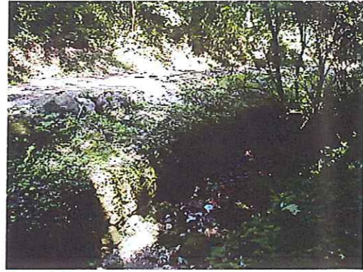
Photo 619: érosion du mur de soutènement en rive gauche, à l'aval de l'ouvrage n°29
