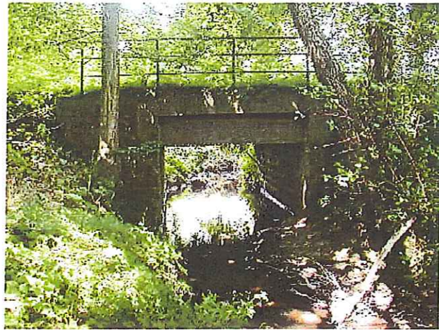
Photo MB 400 : ouvrage 18
