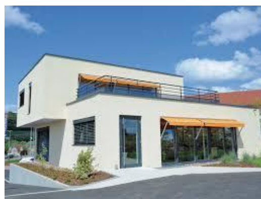
Exemple de toit plat
