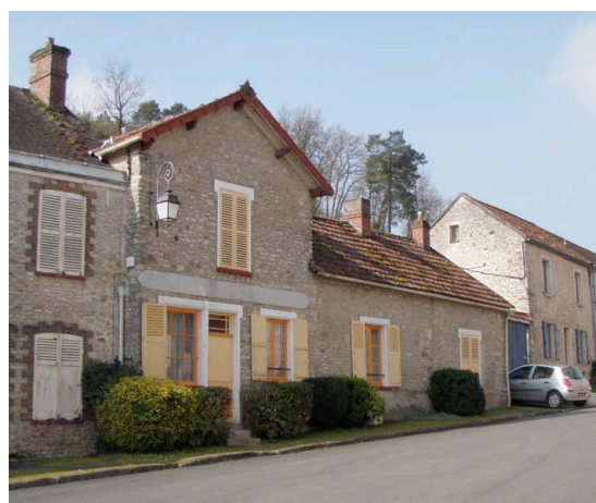
N°3 rue du Haut Pavé
