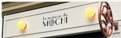
Appliques rondes sur le bandeau de l'enseigne dans un style contemporain
