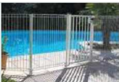
Figure 7 : Barrière de protection ajourée
