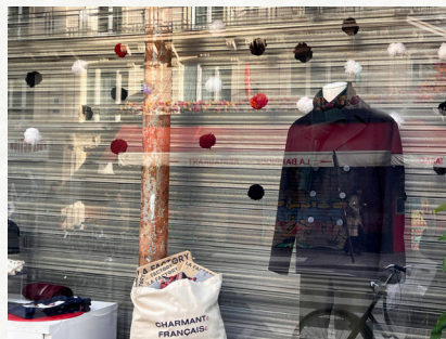
Rideau métallique opaque en aluminium texturé positionné derrière la vitrine
