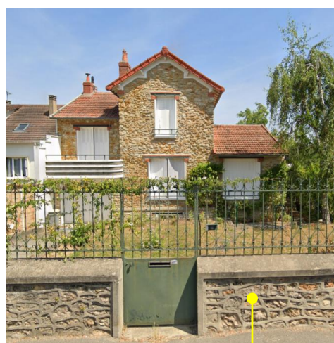
Clôture et mur bahut
