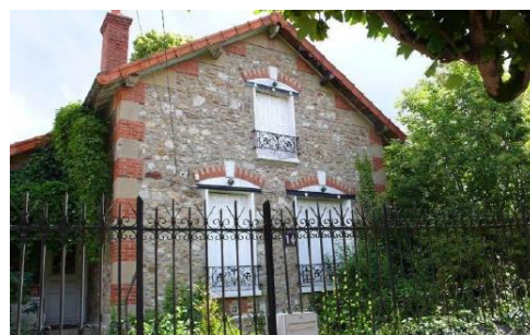
Pavillon au 14, avenue du Général Leclerc
