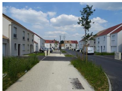
Liaison douce au sein d'un nouveau lotissement
