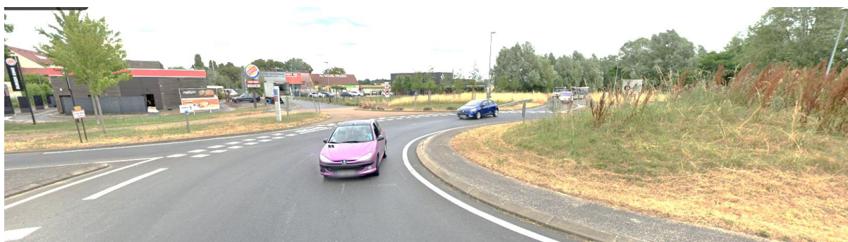
Giratoire d'accès à la ZAE de la Voie Creuse existante
