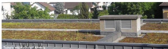
Toiture végétalisée - Annecy
