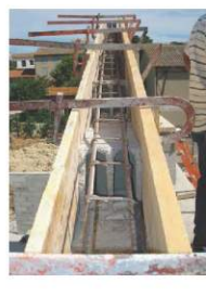
Mise en place d'un chaînage au niveau du rampart d'un bâtiment
