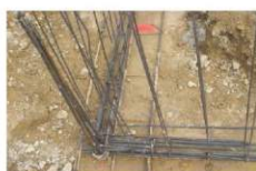
Nœud de chaînage - Continuité mécanique
