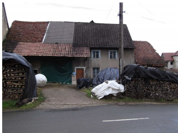
3. Parcelle 64 - Préserver les pentes de toitures, proportion des ouvertures, ordonnancement, modénatures (linteaux...)
