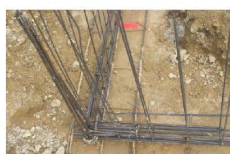
Nœud de chaînage - Continuité mécanique
