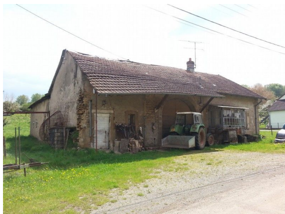
12. parcelle 133 -Préserver les pentes de toitures, aspect et matériaux de couverture, proportion des ouvertures, ordonnancement des façades, modénatures (linteaux...) - préserver la véranda et la voûte de grange
