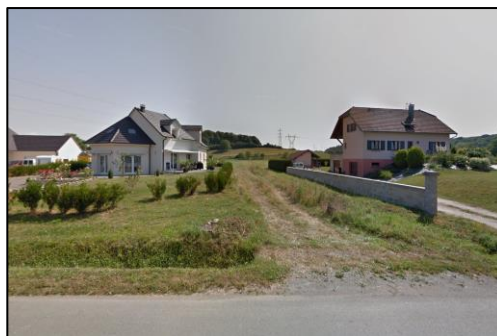
Vue du secteur depuis la rue du Canal
