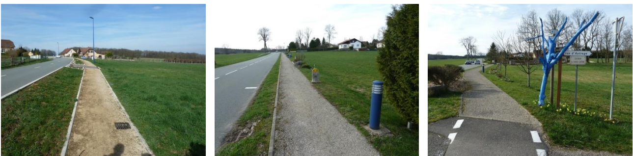
Cheminements piétons existants le long des secteurs B, C et D (AUTB, mars 2017)
