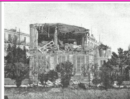
Destruction de bâtiments à Menton (06) suite au séisme de 1887 et à la liquéfaction des sols (Source : Les Tremblements de Terre - FA Fouqué)
