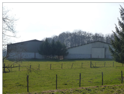
Hangar ou annexe technique
