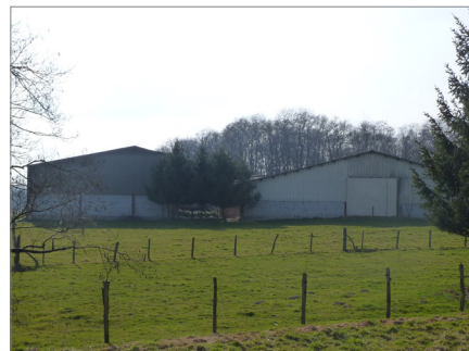
Hangar ou annexe technique
