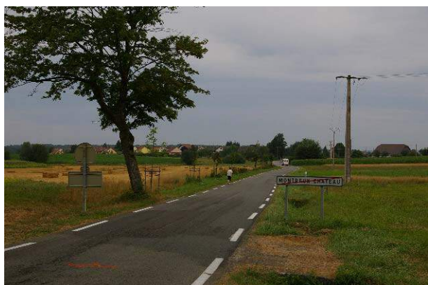
Vue sur Petit-Croix à partir de la sortie de Montreux-Château : le village est immédiatement perceptible. L'espace tampon est fragilisé par son étroitesse.
