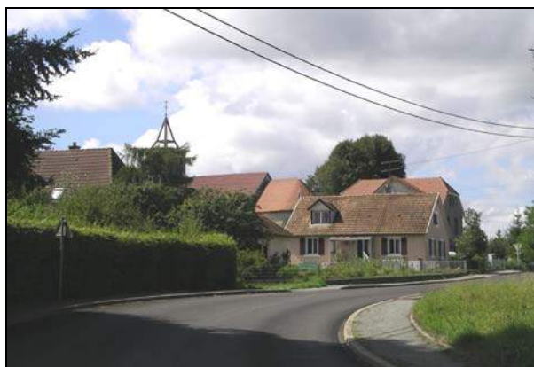
Bâti « groupé » Grande Rue
