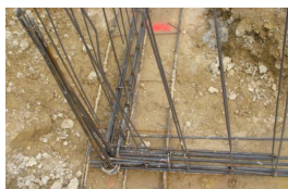
Noeud de chaînage - Continuité mécanique
