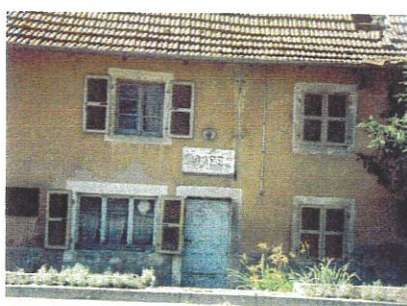
l'ancien café, construction à réhabiliter
