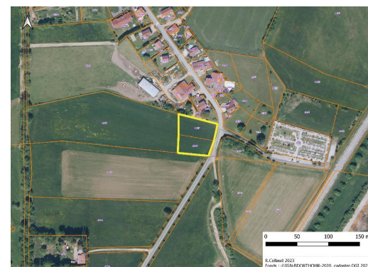
Figure n°3 : Périmètre sud d'étude (Fontaine)
