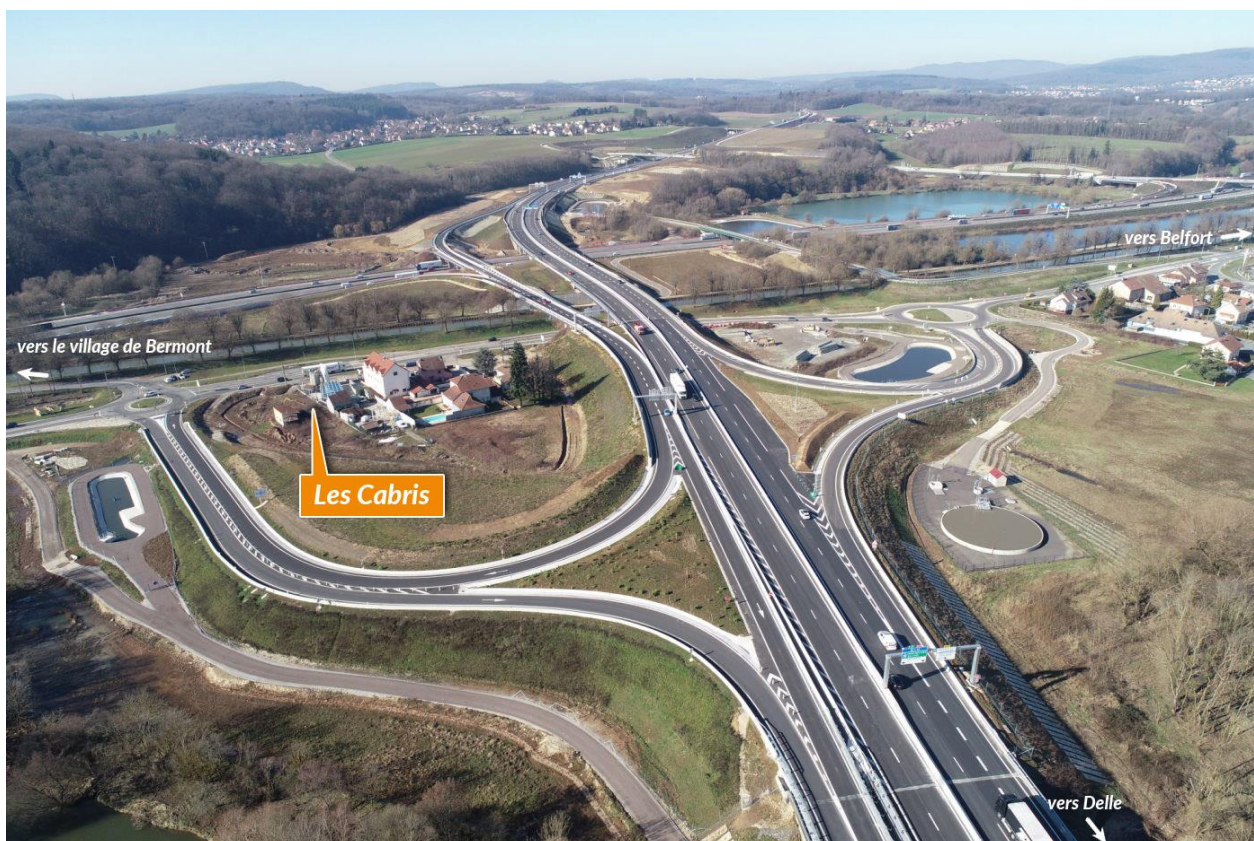
Photo après ouverture de l'échangeur, et situation du secteur des Cabris Source : Vinci Construction)
