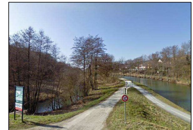
Figure 7 : Le Canal Saône-Doubs dans la plaine alluviale dominant en remblai le lit de la Douce à Froideval
