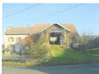
Accès à la partie haute de la construction par une rampe
