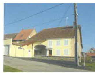
Constructions « en bande » rue des Esserts, avec ajout de garages à l'avant du bâtiment
