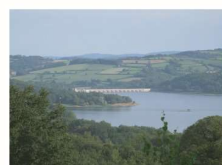
Lac et barrage de Pannecièrre
