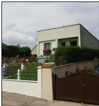
Maison rue Chapelain
