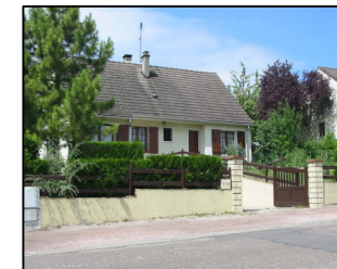
Construction rue Cote Roy
