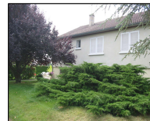
Maison neuve rue du Chablis
