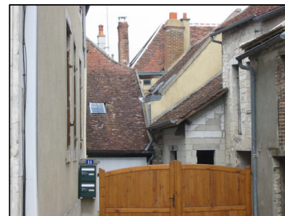
Enchevêtrement de toiture
