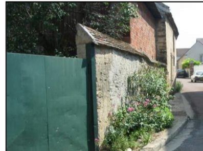
« Chaperon » à pente, recouvert de tuiles plates
