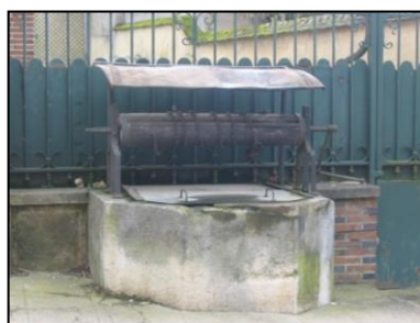
Puits, rue Guy Maupas
