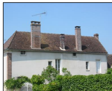
Toiture en petite tuile de Bourgogne
