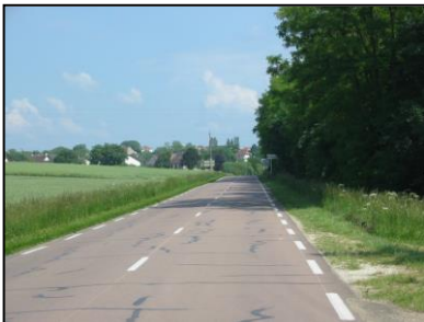
Entrée depuis Pontigny
