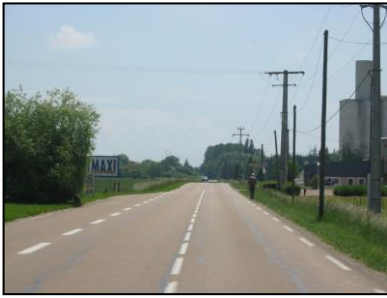
Rectitude de la voie
