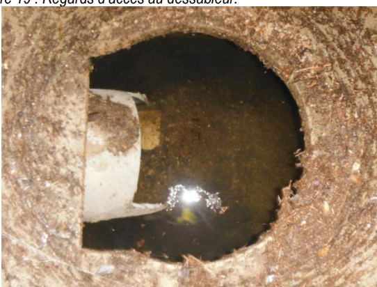
Figure 21 : Canalisation d'arrivée au dessableur.
