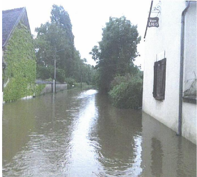
Source : Comité de Pilotage, date inconnue. Figure 75 : Inondations – Rue Grosjean.
