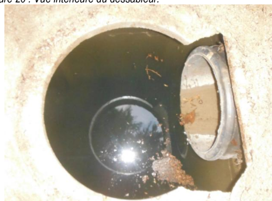
Figure 22 : Canalisation de surverse du dessableur.
