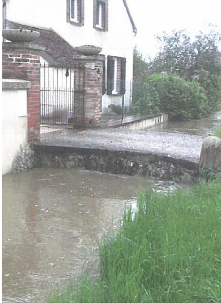
Source : Comité de Pilotage, date inconnue. Figure 74 : Mise en charge des fossés – Rue Grosjean.
