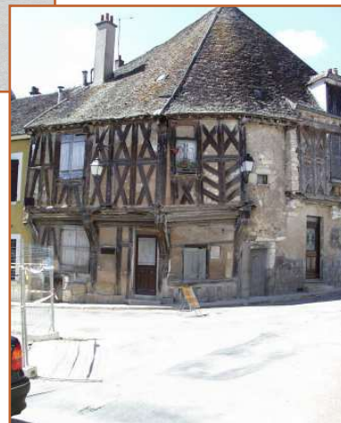
Maison XVème siècle en pan de bois montrant le passé riche de Cravant
