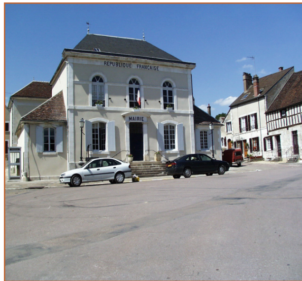
La Mairie, une architecture patricienne
