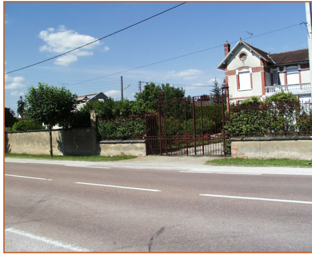
L'habitat pavillonnaire dans les faubourgs le long de la RN6
