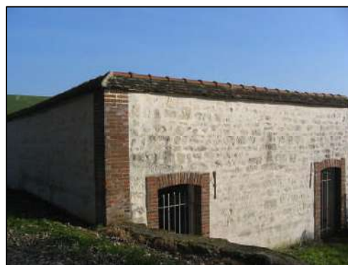
Lavoir, voie communale n° 8
