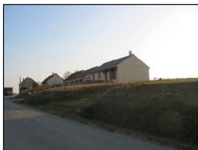
Surplomb de constructions neuves
