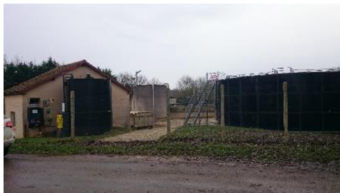
Figure 43 : Station d'épuration de Chailley
