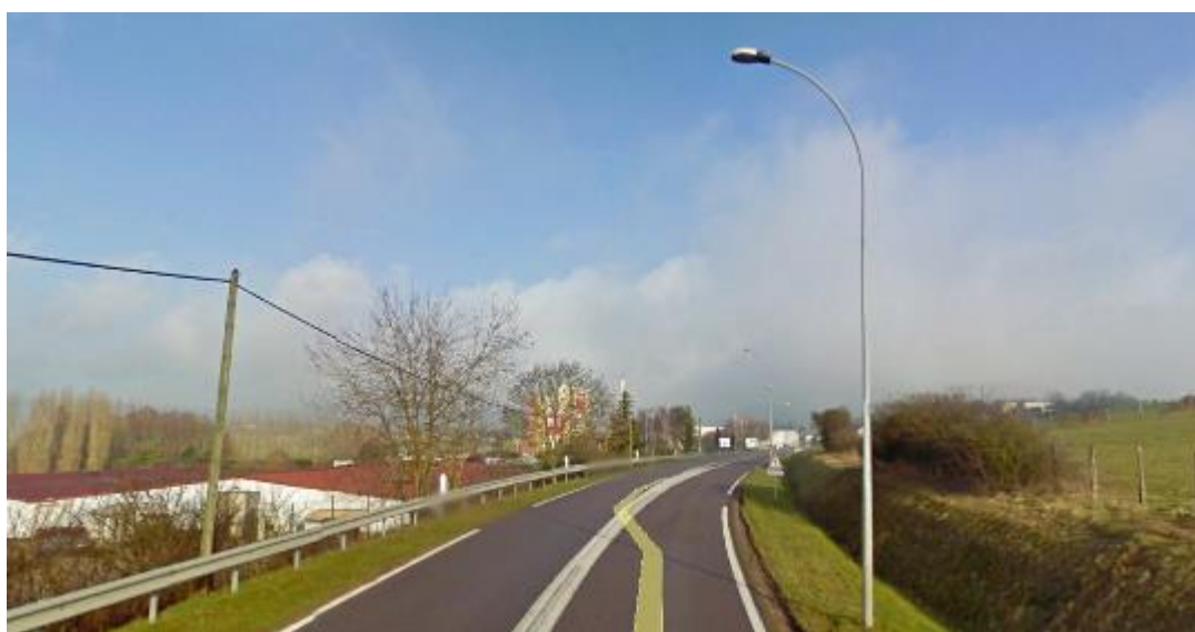
Figure 64 : Vue vers le Nord de la zone d'activités du village depuis la RD 30
