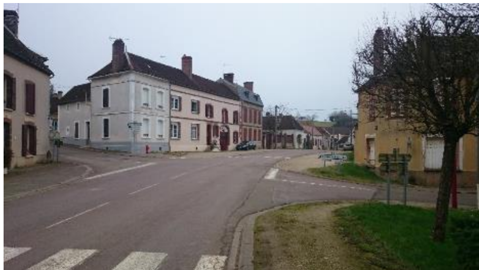
Figure 76 : Maisons à façade enduite, toitures petites tuiles à l'alignement de la RD 30
