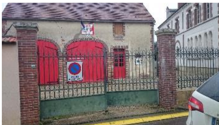
Figure 44 : Centre de protection incendie
