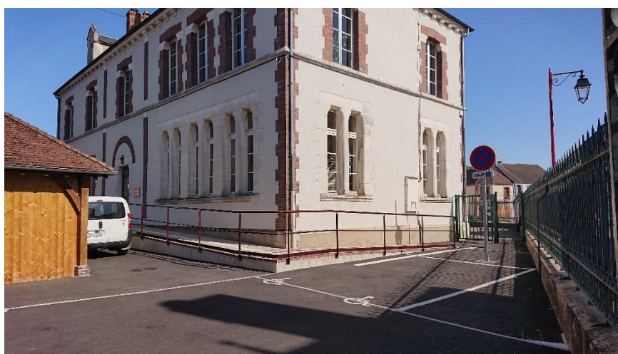
Figure 36 : Accès PMR de la Mairie
