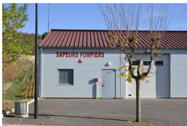
Caserne des pompiers (Source : Perspectives)
