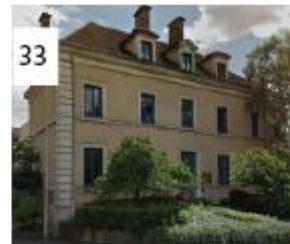
33 Localisation : boulevard Davout
