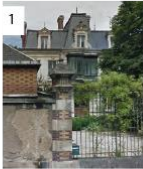
1 Localisation : boulevard Vauban Descriptif : maison bourgeoise avec deux dépendances.
