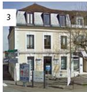
Localisation : avenue Gambetta
