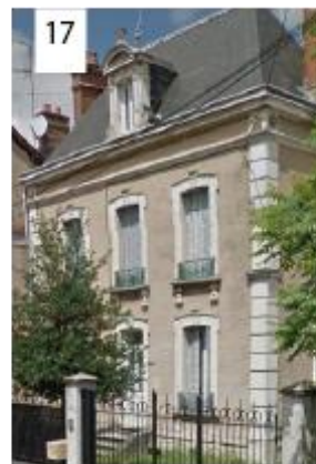
Localisation : avenue Gambetta
