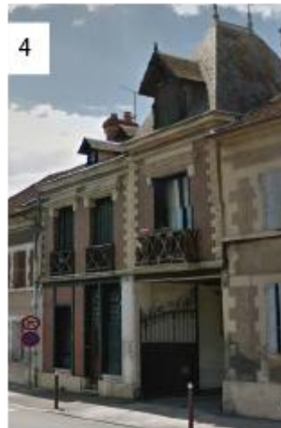
Localisation : rue du Bourneuil
