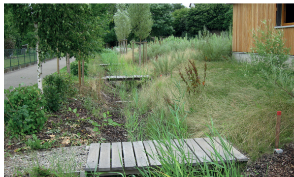
Exemple de noue pluviale : Sainte-Croix aux-Mines(68)
