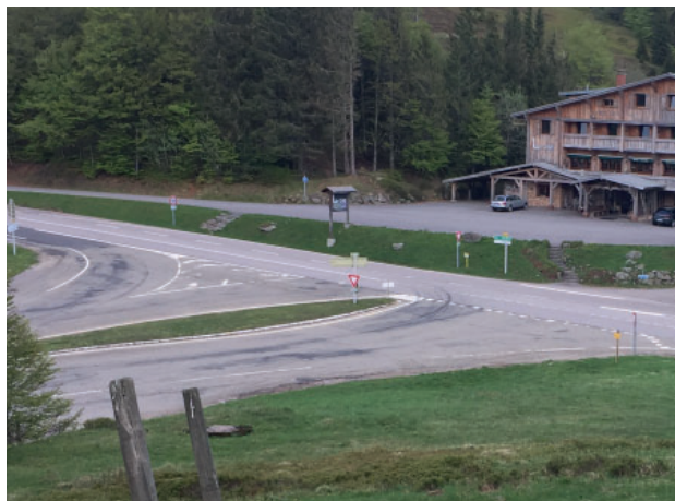
Le carrefour aménagé en contrebas de l'hôtel restaurant Le Collet
